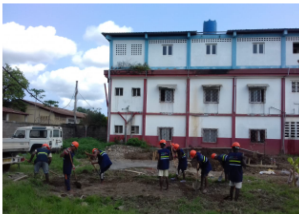
Travaux préparatoires pour les forages
